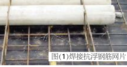
图(1)焊接抗浮钢筋网片
